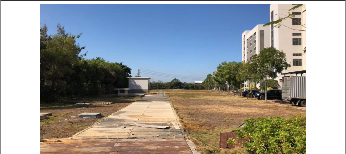
园区应急事故池（地埋式）
